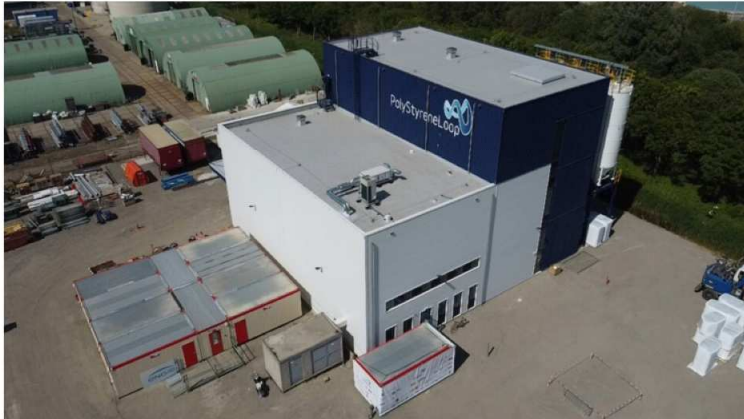
PolyStyreneLoop in Terneuzen
