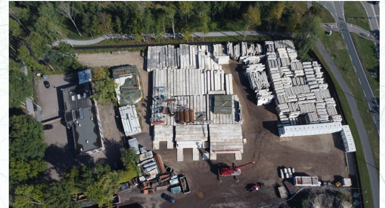
Opslag losse prefab betonnen elementen
