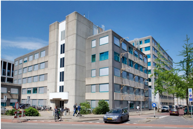
Gebouw met prefab beton constructie
