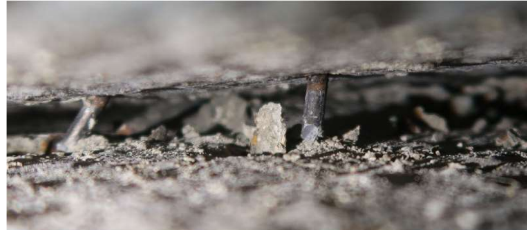
Proefstuk T32, gebroken diagonaalstaven van de tralieligger
