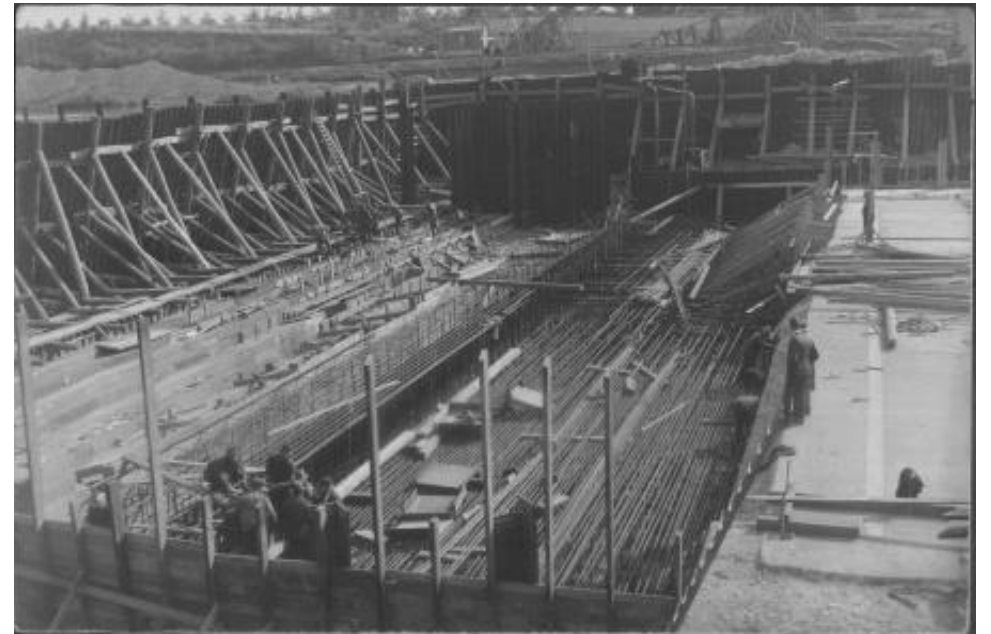
Aanbrengen wapening woelbak, de stuw bij Sambeek
