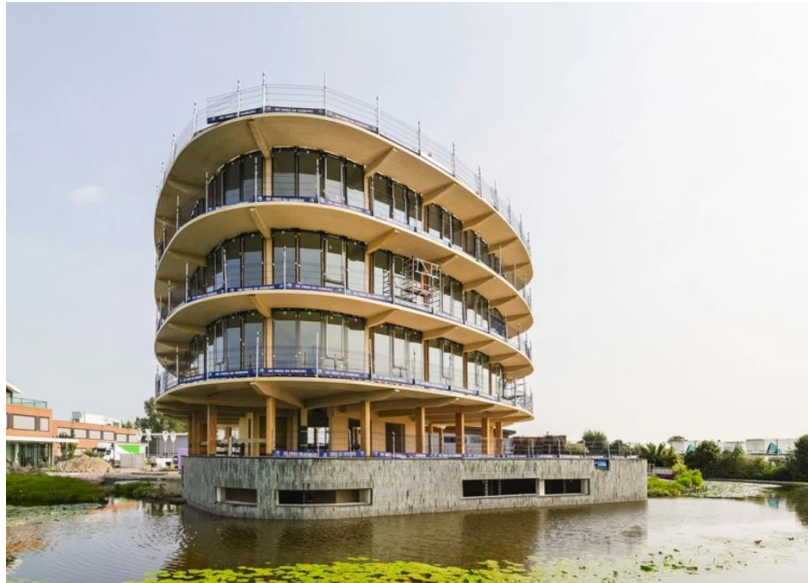
2023/2024 Parel in de polder Bouwstroom met accu
